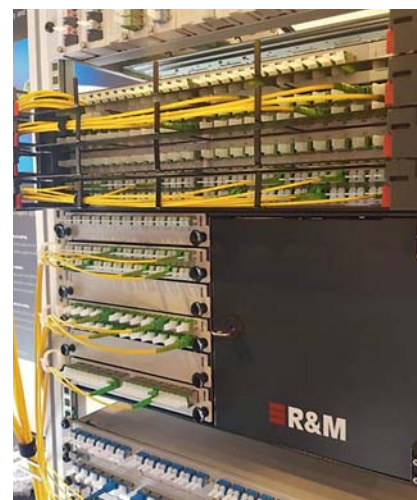
Hoher Standard: Glasfaser-Verteiler mit mehreren Patcheinschüben.
