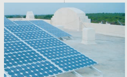
Immer mehr Betriebe setzen auf Solarstromanlagen zur Erzeugung von Eigenstrom, um ihren Bedarf aus dem öffentlichen Netz zusätzlich zu reduzieren.
