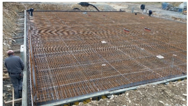
> Bild 12b: Beispiel für Darstellung der Teile der Erdungsanlage aus unterschiedlichen Blickwinkeln - Ansicht 2
